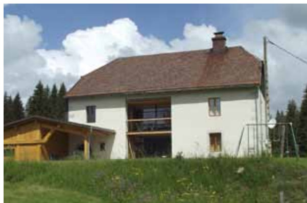
◀ Fig. 46 – Utilisation de baies d'atelier existantes pour éclairer les pièces de vie créées
