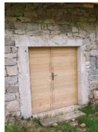
▼ Fig. 77 – Encadrement de porte créée en pierres de taille
