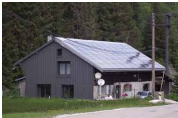
▼ Fig. 64 – Solaire photovoltaïque intégré à la toiture, occupant la totalité du toit
