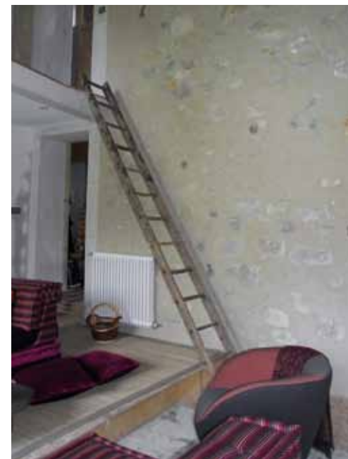
▲ Fig. 76 – Enduit à la chaux pierres vues en intérieur
