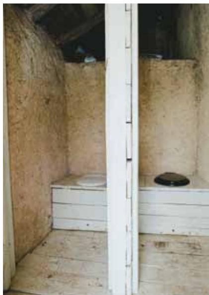
▲ Fig. 87 – Toilettes sèches extérieures existantes et conservées
