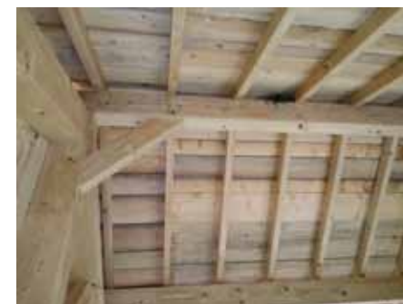
▶ Fig. 79 – Charpente nouvelle réalisée en bois massif
