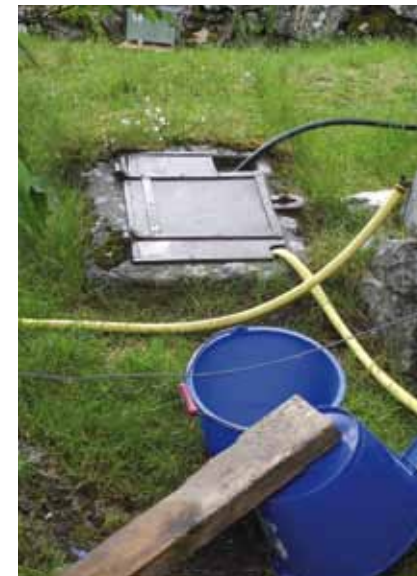
▼ Fig. 86 – Utiliser l'eau des citernes pour l'arrosage extérieur
