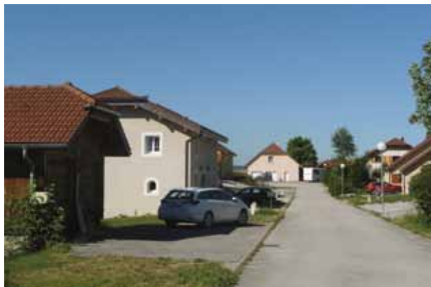
▲ Fig. 28 – Maisons individuelles en maçonnerie, Lamoura
