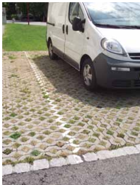
▲ Fig. 88 – Dalles alvéolées pour places de stationnement
