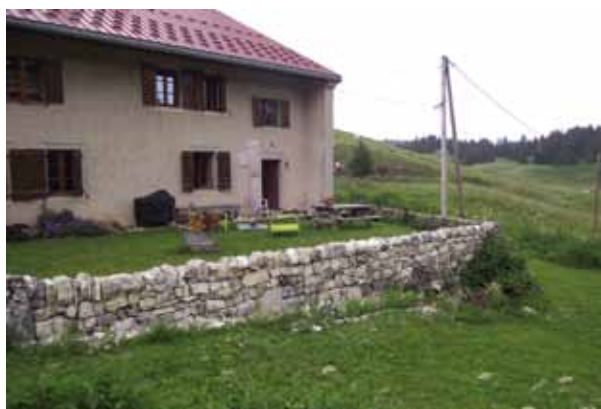
► Fig. 75 – Terrasse enherbée créée par le biais d'un mur de soutènement
