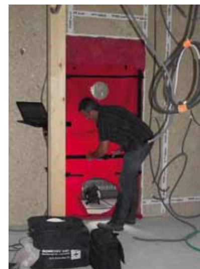
▲ Fig. 57 – Test d'infiltrométrie permettant de vérifier la bonne étanchéité à l'air
